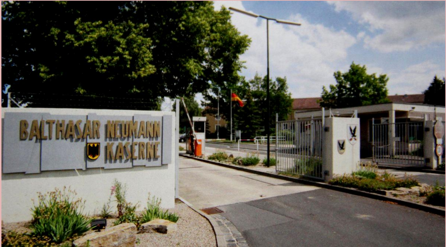
Die Balthasar - Neumann - Kaserne in Veitshöchheim, November 1993-2002, die letzte Heimat der stolzen Panzerbrigade 36.
